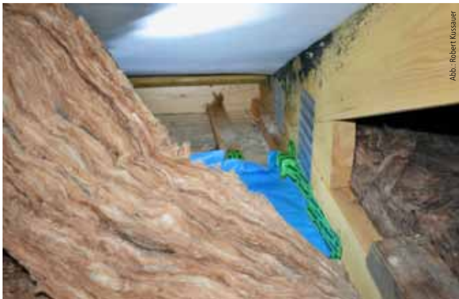
Abb. 3: Fehlstellen in der Luftdichtheitsebene können zu Schimmelbefall in angrenzenden Räumen führen.
