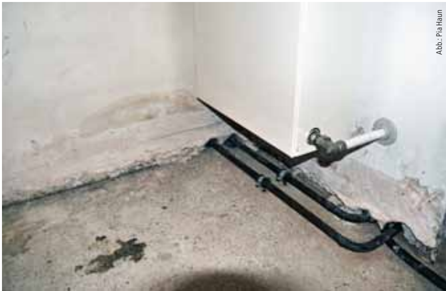
Abb. 4: Um Schimmelschäden in Fußböden abzuschotten, muss in der Bestandsaufnahme ermittelt werden, ob und wo es beispielsweise Wand- oder Deckendurchbrüche gibt.
